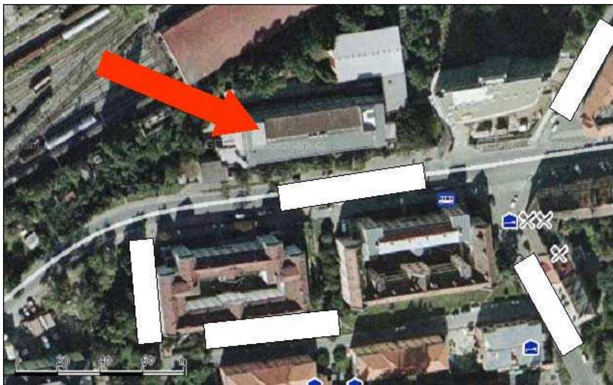
Obr. 1 - Letecký snímek předmětu energetického auditu a nejbližšího okolí
