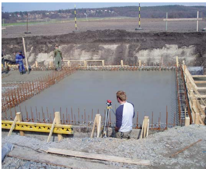
Výstavba čistírny odpadních vod, Loučeň
