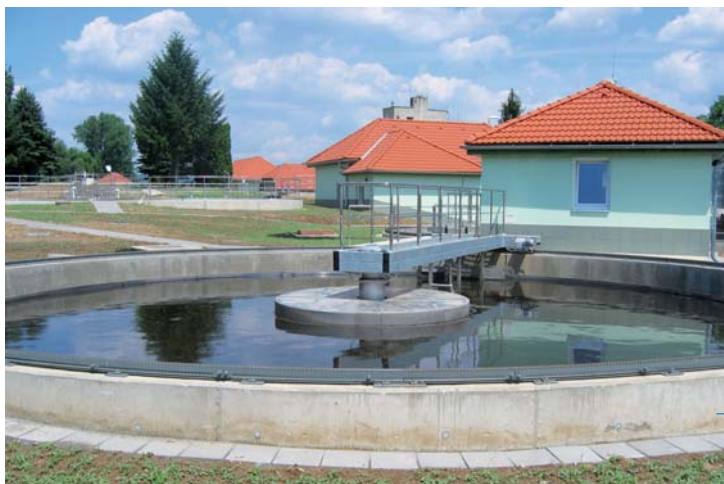
Čistírna odpadních vod, Tišnov
